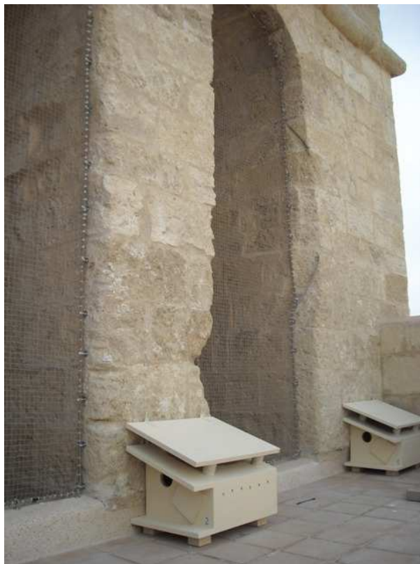
Foto 11. Nidi artificiali accostati alla torre campanaria, non visibili dal basso.
