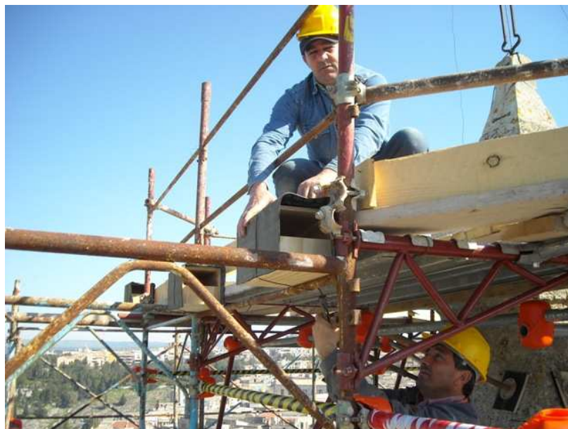
Foto 1. Installazione cassette nido "da cantiere".
