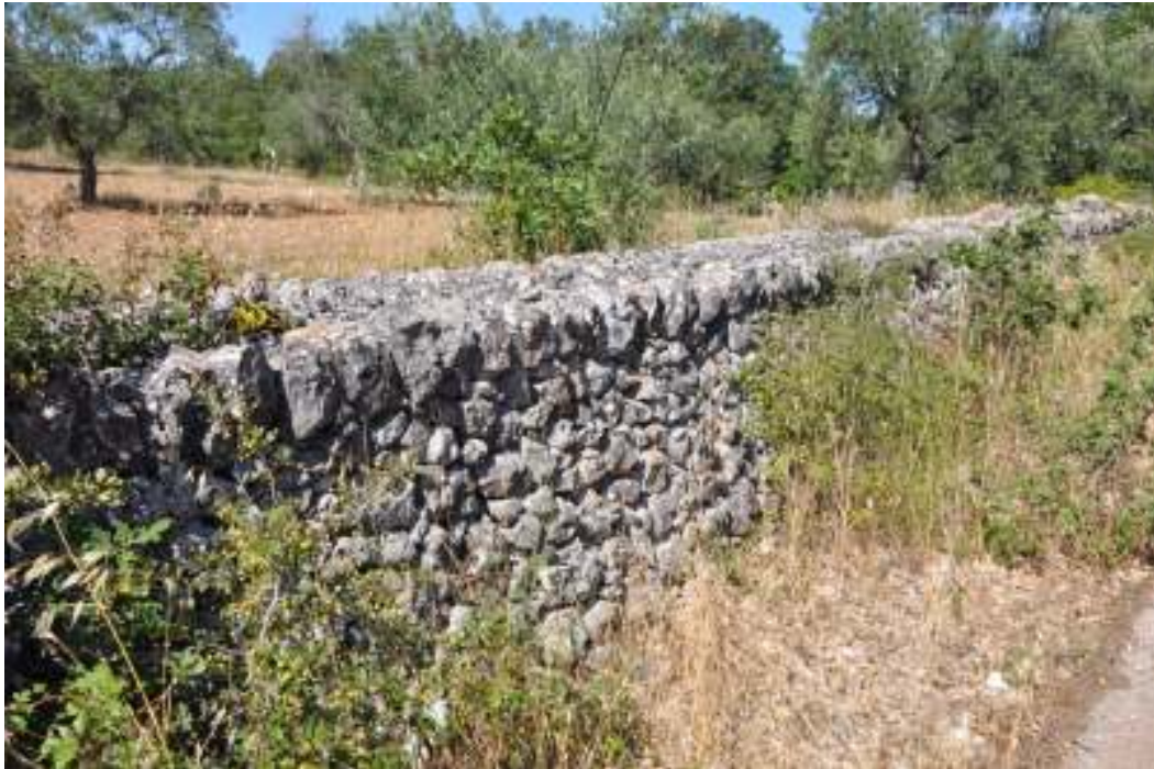
Figura 1 - Tipica struttura di una parete a secco a "singolo corvello" nel parco della Murgia
