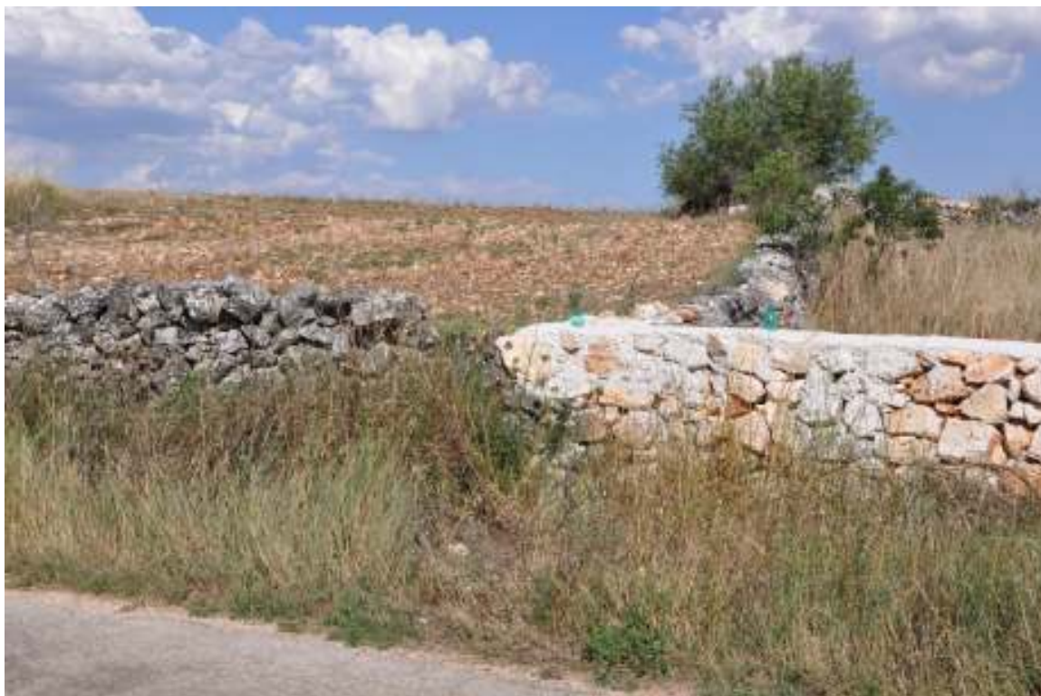
Figura 6 - Esempio di intervento dissonante con il manufatto preesistente.
