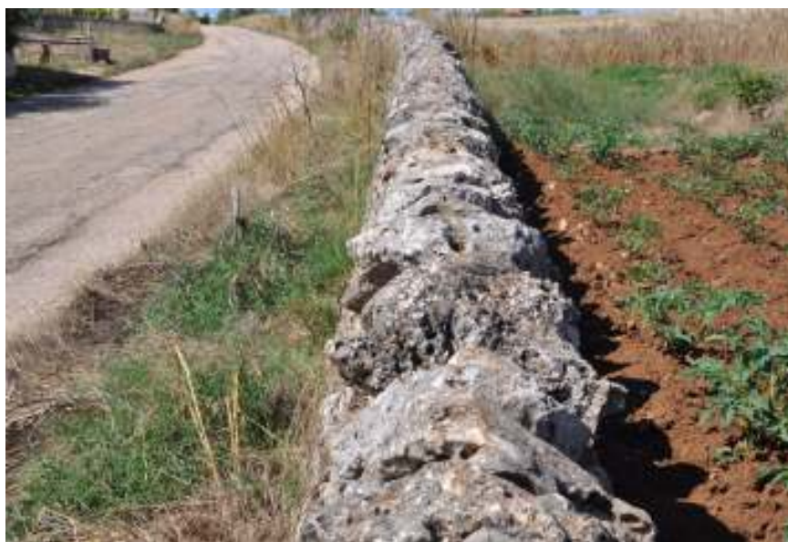
Figura 3 - Vista dall'alto di parete a "singolo corvello".
