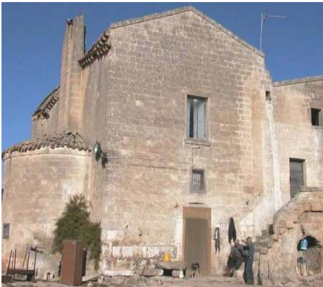
Figura 8 - Il tufo nelle strutture in elevazione.
