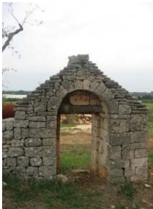
Figura 10 - portale in pietra a secco d'accesso alla pertinenza della costruzione rurale
