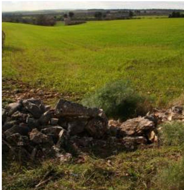
Figura 4-6 - I muretti a secco rappresentano spesso l'unico elemento di diversificazione strutturale degli ambienti agrari. Ripristino e manutenzione sono fondamentali per la conservazione e la gestione faunistica.
