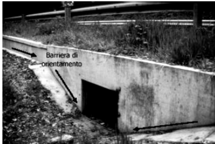
Figura 4-12 - Sottopasso con invito e barriera di contenimento per l'attraversamento di anfibi e altre specie di piccola taglia.
