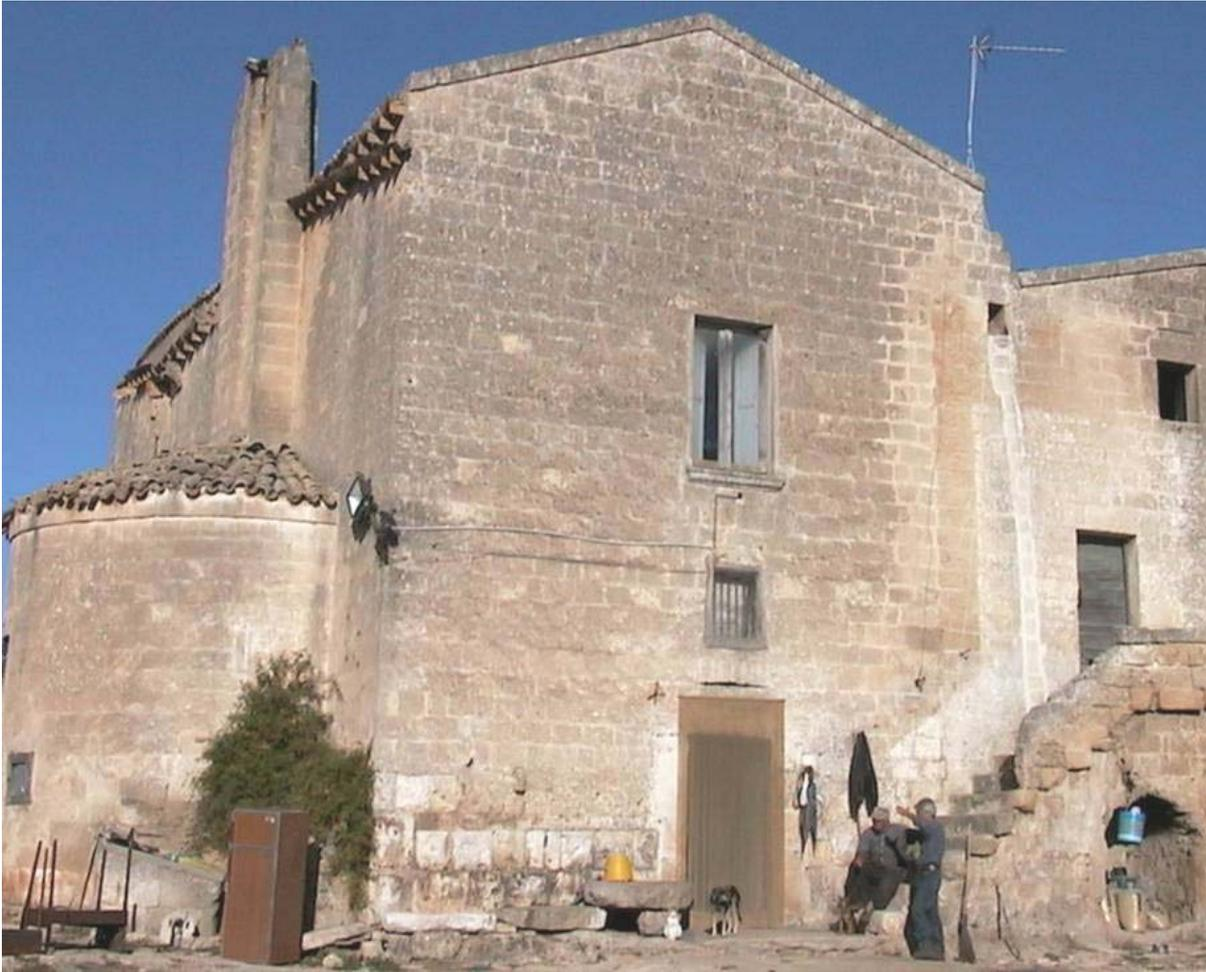
*Figura 8 - Il tufo nelle strutture in elevazione.*
