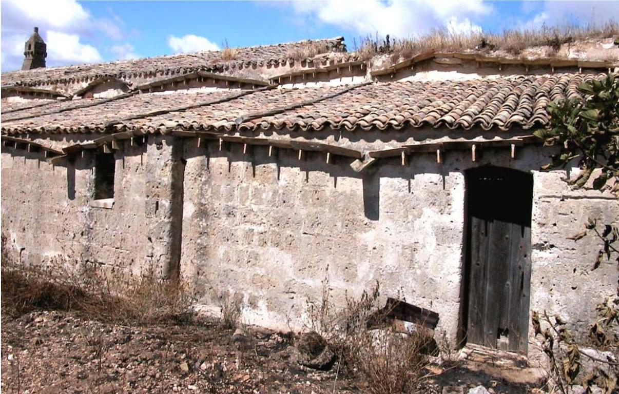
*Figura 10 - Il laterizio (cotto) rappresenta il materiale più utilizzato nelle coperture in coppi e negli impianti tecnologici per la raccolta dell'acqua*
