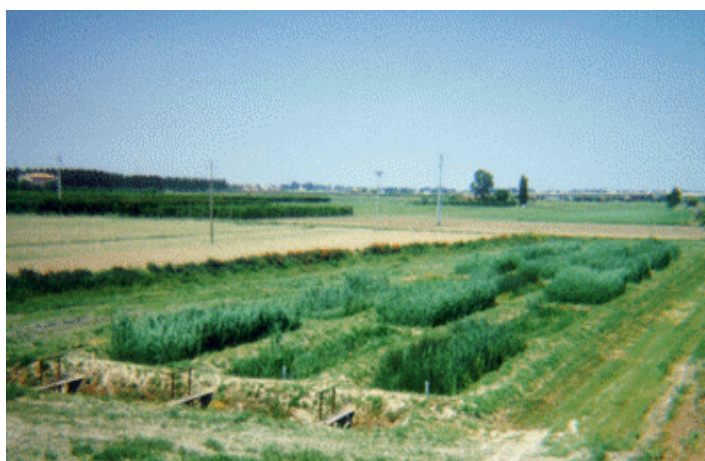
Figura 4-44 – Esempio di impianto di fitodepurazione a flusso subsuperficiale.
